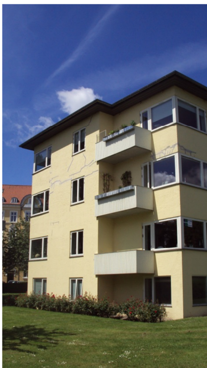
4. Der er udført partielle fugereparationer i murværket.
